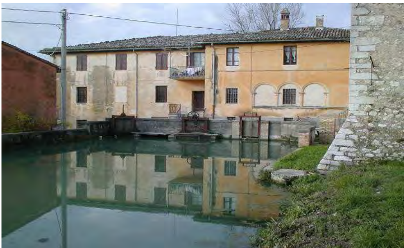
Vasca di carico (“accolta”) sul Canale dei Molini
